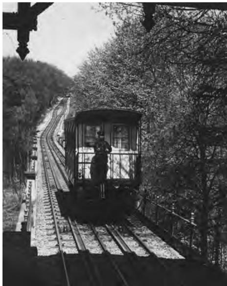
Technisch ist die Nerobergbahn eine Drahtseil-Zahnstangen-Bahn mit Wasserballastantrieb. Beide Wagen sind mit dem Seil miteinander verbunden. In den Tank des in der Bergstation stehenden Wagens wird jeweils so viel Wasser eingelassen wie erforderlich ist, um den anderen Waggon aus der Talstation hinauf zu
